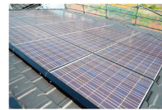
外部側工事完了
