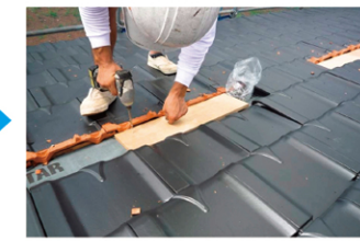
留め付け下地施工 （重要な下地工事です）
