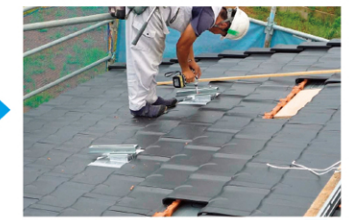
留め付け金具の設置 （支持瓦という専用瓦です）
