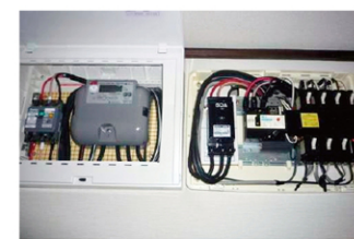
分電盤への交流配線工事
