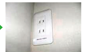
自立コンセント設置 ※SHARPサンビスタの場合 （非常時のコンセントです）
