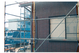
足場設置 （転落防止措置を行います）
