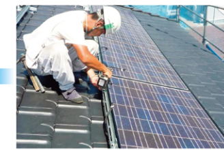
モジュールの設置 （専用金具で締め付けます）
