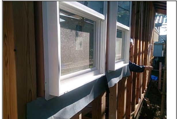
2016.11.15 2階寝室 サッシ廻り 防水施工 状況
