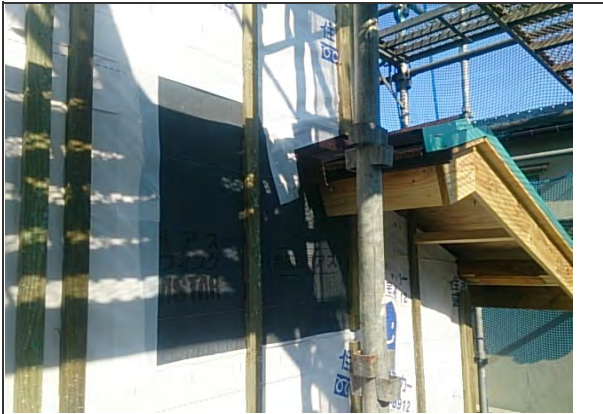
2016.11.15 1階リビング サッシ廻り 防水施工 状況
