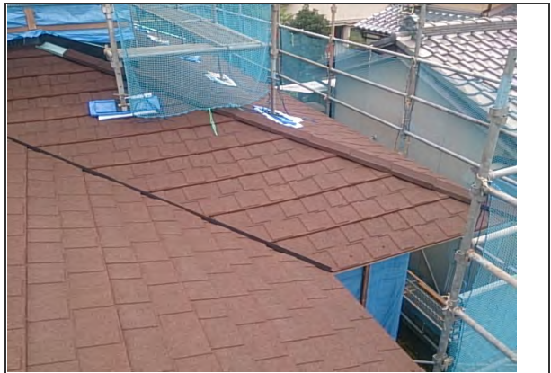
屋根材 施工状況 (4)
