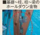
■基礎～柱、柱～梁のホールダウン金物
