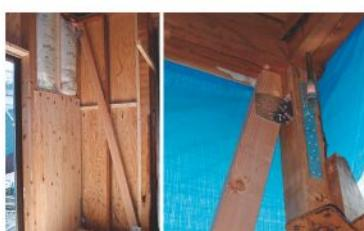
木造在来軸組み工法において「柱」と「梁」
